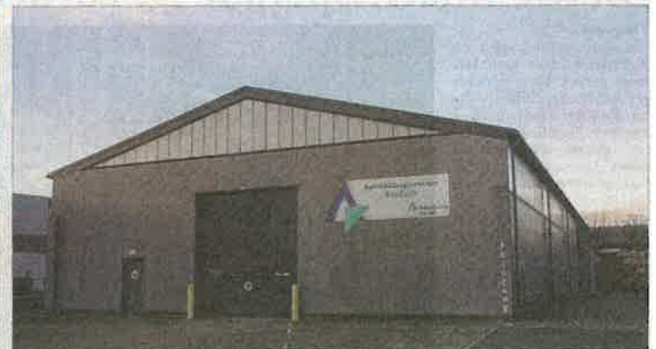
Das Berufsbildungszentrum des Arbeitsamtes in der Friedensstraße soll fester Bestandteil des Bildungsdreiecks bleiben. Die große Halle der Maurerschule könnte allerdings noch besser genutzt werden, findet die Ministerin.
